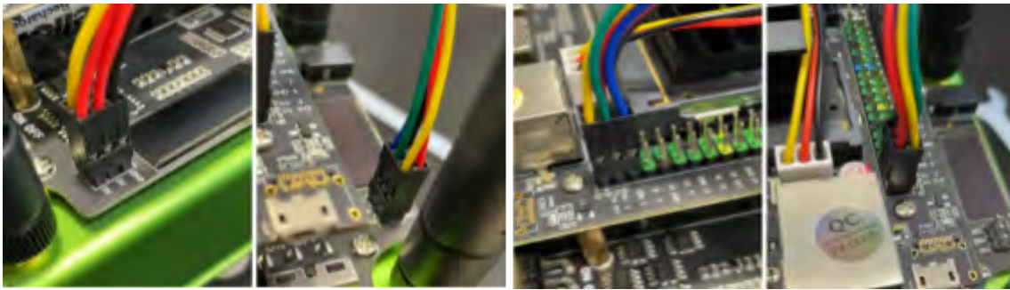
תמונה 23. הרכבת צמת תקשורת ואספקת מתח
